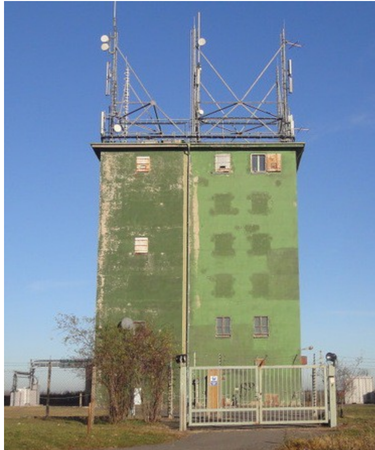
Fernmeldeturm der ehemaligen Bezirksrichtfunkzentrale in Dresden-Gompitz
